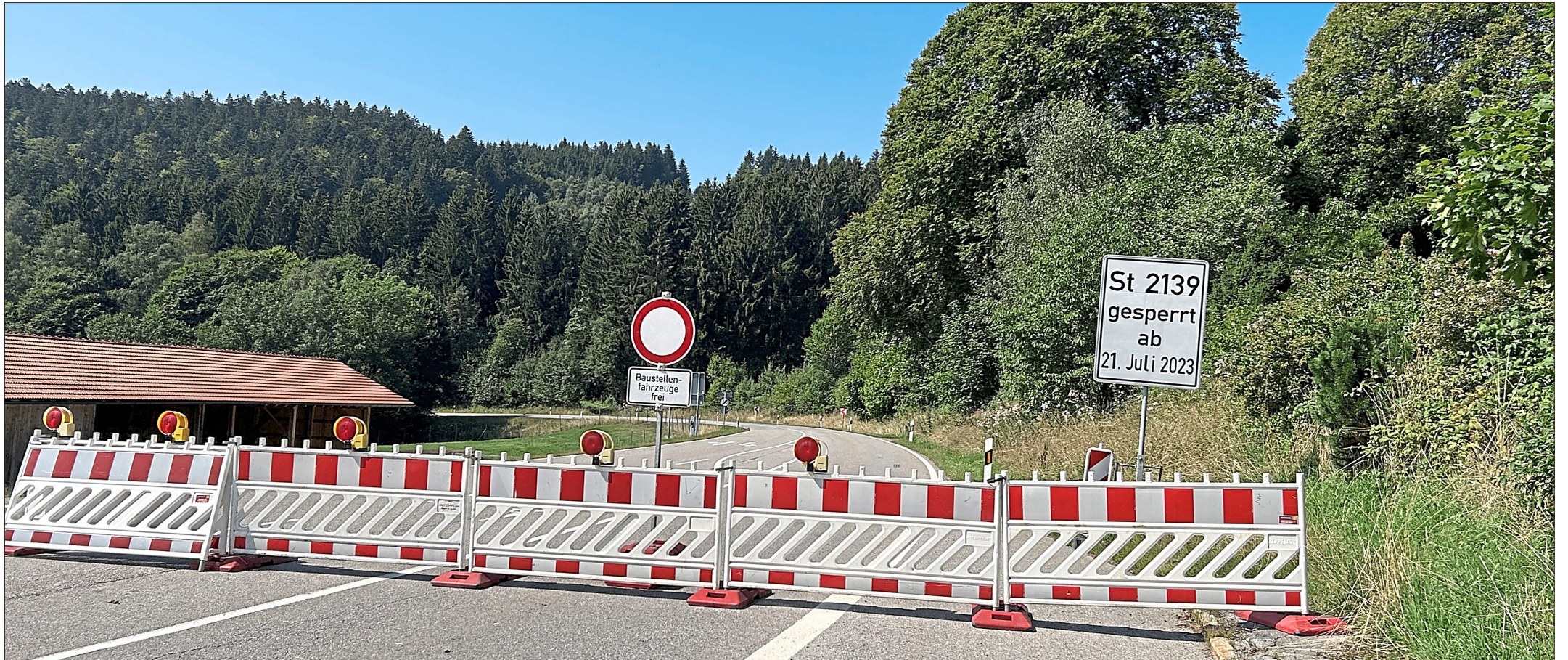
Dieses Bild bietet sich aktuell den Autofahrern in Grün. Ein „Anlieger frei“-Schild sucht man hier vergeblich. Es dürfen somit nur Baustellenfahrzeuge passieren, auch wenn die Sperre halbseitig offen ist. Manche Autofahrer interessiert das jedoch nicht. Fotos: Patrick Beckerle
