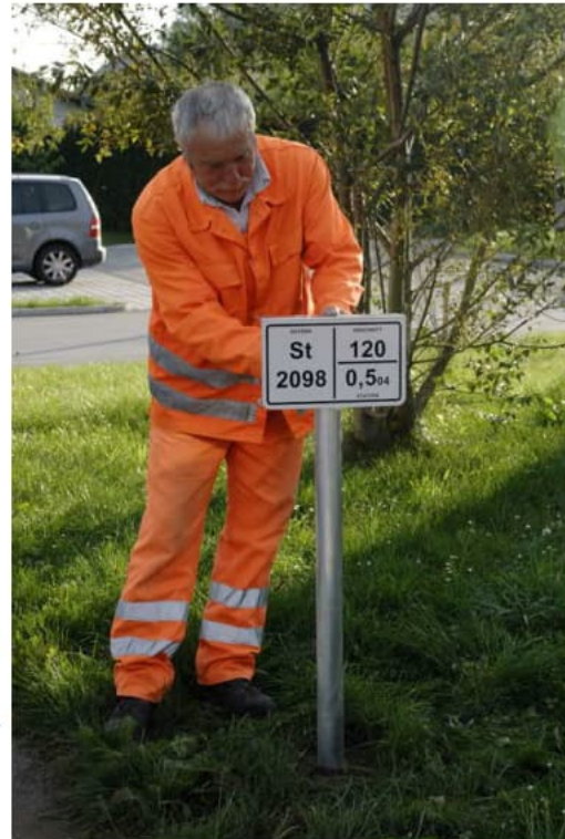
Ein Stationierungszeichen wird befestigt. © Staatsbauverwaltung
