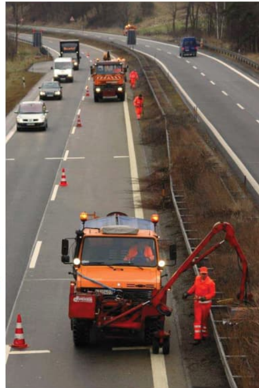
Die Gehölzpflege im Mittelstreifen einer Autobahn erfordert umfangreiche Absicherungsmaßnahmen. © Staatsbauverwaltung
