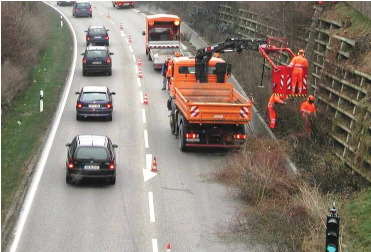
Straßenwärter schneiden die Gehölze im Straßenraum zurück. © Staatsbauverwaltung
