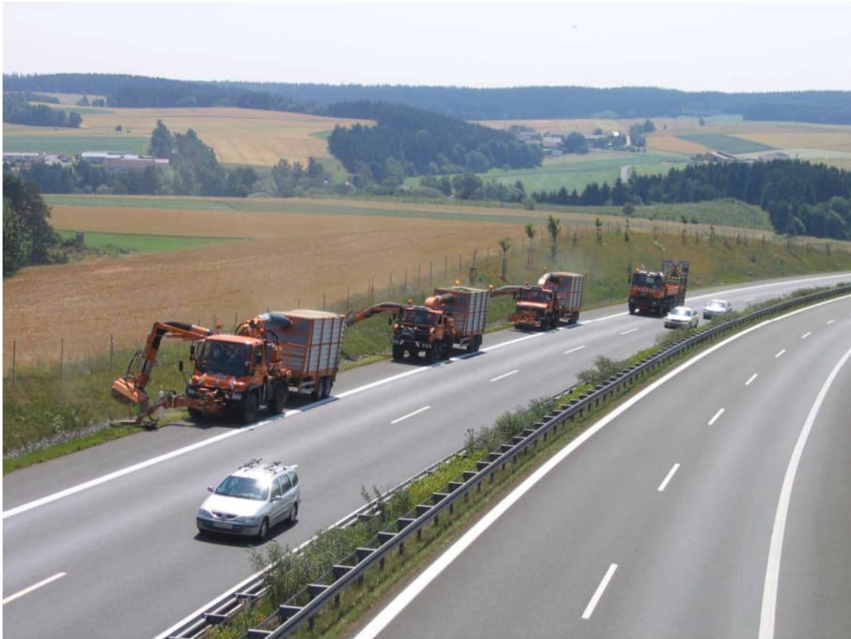
Mitarbeiter der Autobahnmeisterei mähen die Rasenflächen. © Staatsbauverwaltung
